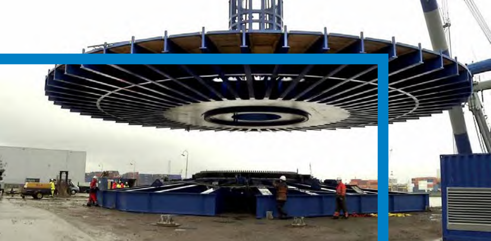
Installation af drejeskive på logistikcenteret i Rotterdam, som markant øger lagerkapaciteten for søkabler.
